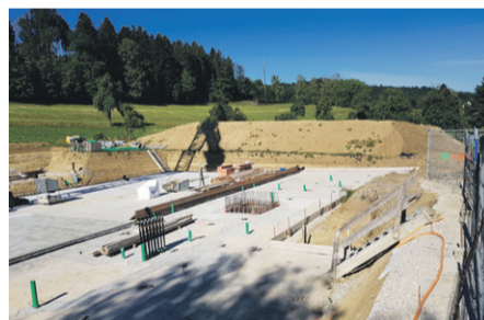
Die Bodenplatten werden verlegt.
